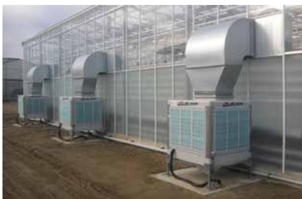
Instalación AD- 15-VS en invernadero
